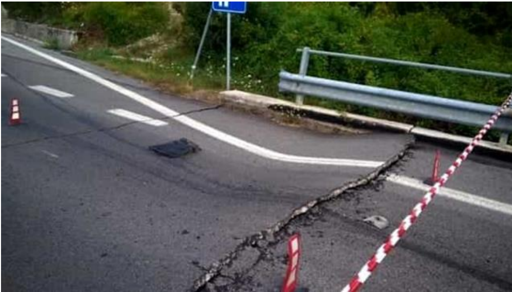
Fig. 15) Fenomeni di fagliazione superficiale verificatisi con il terremoto del 30.10.2016
